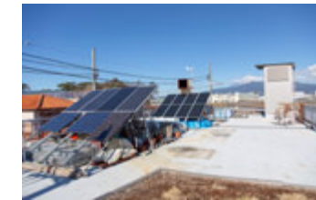
屋上には太陽光パネル
